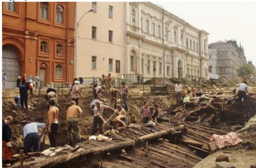
Москва. Деревянная мостовая XVII века, найденная в ходе раскопок в Историческом проезде, 1988 год
